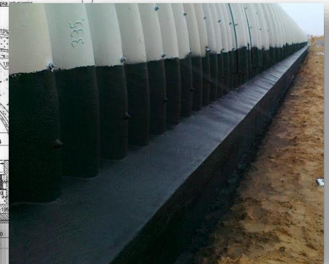
zamknięcie ubitą gliną na wlocie i wylocie na długości 2m
